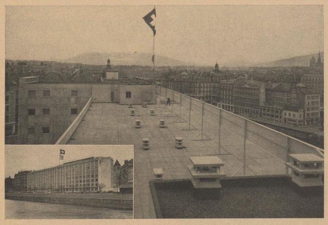
Hôtel du Rhône à Genève. — Etanchéité des toitures terrasses exécutées en asphalte souple « Système Hirschy » recouverte par dallettes en ciment teinté.
