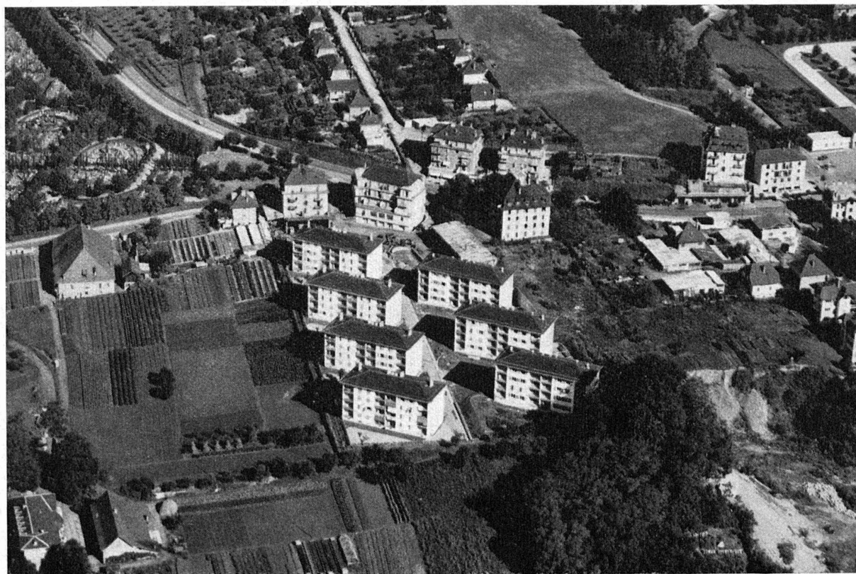
Groupe de 7 immeubles locatifs dont la menuiserie est presque totalement l'œuvre de la FABRIQUE COOPÉRATIVE DE MENUISERIE DE RENENS. — Architecte : M. Jacques Favarger, à Lausanne Aéro-photo Wurgler, pilote Schuller. Voir page 82 du présent numéro.
