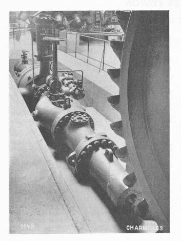
Fig. 1. — L'injecteur bifurqué d'une des turbines de la centrale de Dixence-Chandoline.
