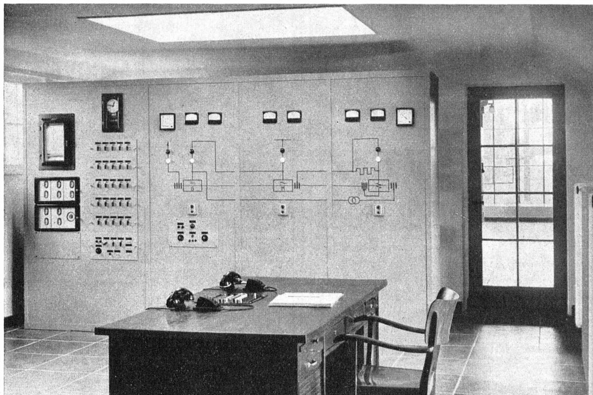
Installation de télécommande sur réseau de distribution d'électricité 15 kV à Düşhorn (Allemagne). — LANDIS & GYR S. A., Zoug.
