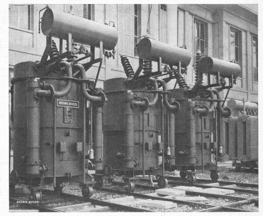
Fig. 51. — Groupe de transformateurs à 135 kV refroidis par circulation d'huile dans des réfrigérants à eau, au poste extérieur de la centrale de Lavey.
