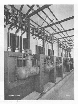
Disjoncteur pneumatique tripolaire dans l'installation de distribution à 10 kV de l'usine de Lavey, vu du côté du couloir de service.
