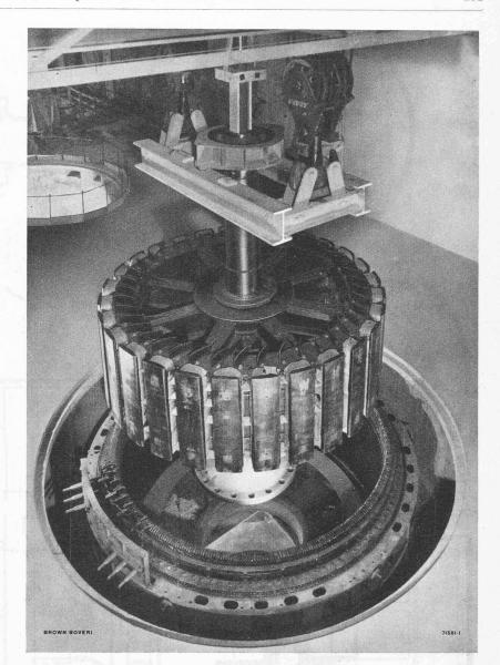
Fig. 47. — Mise en place du rotor de l'un des alternateurs.
