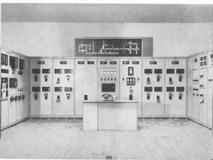
Fig. 62. — Centrale souterraine, poste de commande pour les services internes.
