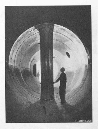
Fig. 39. — Intérieur de l'une des bâches spirales de la turbine Kaplan-Charmilles, avec vanne ouverte.
