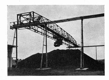
USINE A GAZ DE LAUSANNE Pont roulant sur le parc à coke
