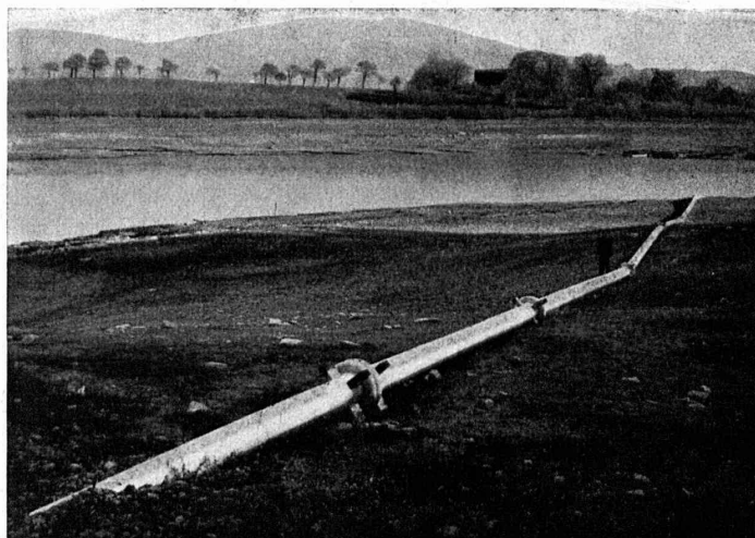
CONDUITE D'AÉRATION AU LAC DE BRET Ø 300 mm - Longueur: 350 m, en tôle d'acier SM, ép. 7 mm
