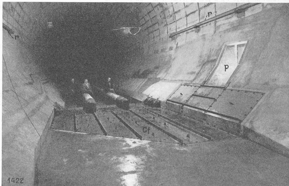
Fig. 6. — Organes du dessableur situés dans le tunnel, vus de l'aval. Cf : couverture de la fosse des canaux en tôle, p : ouverture pour l'accès au dessableur et au tunnel, à fermer par des panneaux en tôle, r : rails du pont roulant.
