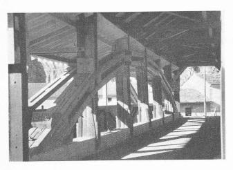
Fig. 19. — Pont de la Bâtiaz. Arc renforcé.
