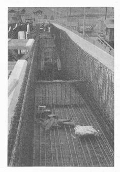
Fig. 10. — Pont de Noës. Armature.
