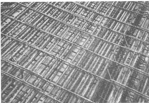
Fig. 9. — Pont de Noës. Armature Caron.
