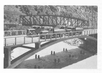
Fig. 5. — Pont sur la Massa. Essais de charge.
