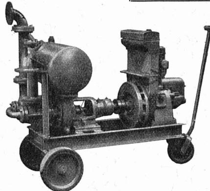
Débits de 1 à 500 litres/seconde. — Pas de soupape de pied, ni de clapet dans la tubulure d'aspiration. — Aucune pompe à vide de secours. — Réamorçage automatique immédiat, même si de l'air est entré dans le tuyau d'aspiration. — Pas de surfaces de contact à frottement et s'usant; par conséquent pas de contretemps même pour l'élevation de la boue, du sable ou du gravier.
