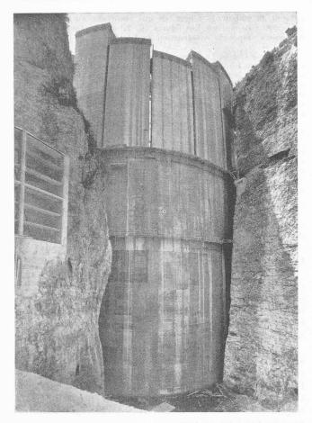
Fig. 28. — Vue d'amont du barrage-voûte de S. Giustina ; état des travaux en juillet 1949.
