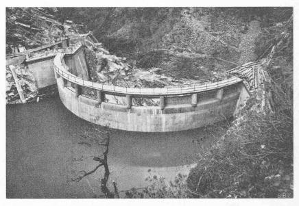
Fig. 23. — Barrage de Panigai du bassin de compensation de l'usine de Pedesina sur le Bitto; vue d'amont du barrage en voûte mince.
