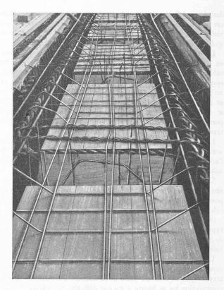
Fig. 22. — Coffrage pour pont de 40 t en béton armé à nervures, construction Giroud, pour véhicules ferroviaires, construit pour une charge de trafic maximum de 110 t, avec armature posée.
