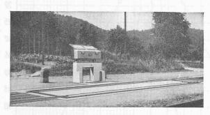
Fig. 28. — Pont à bascule de 40 t pour véhicules ferroviaires et routiers avec interruption de voie, pont en béton armé à nervures, système Giroud, longueur utile 8,4 m, construit pour une charge maximum de
