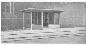
Fig. 29. — Pont à bascule de 50 t avec interruption de voie, avec pont en béton armé à nervures, système Giroud, longueur utile 8,4 m, construit pour une charge maximum de 70 t, avec colonne montée dans une guérite.
