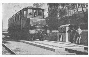
Fig. 27. — Pont à bascule de 40 t avec interruption de voie, avec pont en béton armé à nervures, système Giroud, longueur utile 8,4 m, construit pour une charge maximum de 110 t.
