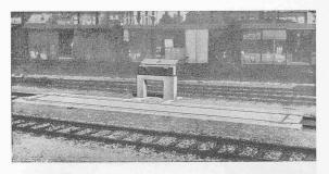
Fig. 19. — Pont à bascule de 70 t, avec interruption de voie, construction à nervures, système Giroud; construction mixte avec deux poutres principales métalliques, enrobées de béton; longueur totale 11,6 m, construit pour une charge maximum de 120 t.
