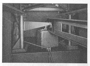
Fig. 6. — Supports d'angle et jeu de leviers pour un pont à bascule de 50 t, sans interruption de voie, avec pont en acier, calage hydro-électrique, jeu de leviers en construction sans torsion, muni de couteaux réglables et interchangeables. A gauche sont visibles la presse hydraulique, sur laquelle repose le support d'angle, ainsi que la ligne de pression.
