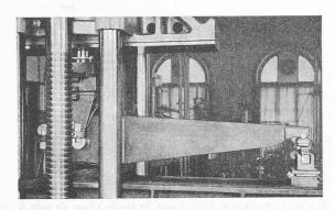
Fig. 10. — Supports d'angle avec supports à billes, leviers d'angle avec supports pour pont à bascule de 50 t sous la « Pulsierpresse » pour vérification sur effort continu.
