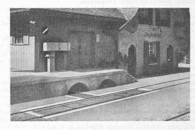
Fig. 17. — Pont à bascule de 45 t pour voie étroite, sans interruption de voie, avec treuil de calage à main, longueur du pont 7,5 m, monté dans une voie de gare pour service de transit.
