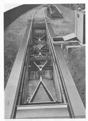
Fig. 1. — Pont à bascule pour wagons, capacité de pesage 100 t, sans interruption de voie, avec treuil de calage. Le pont de 16 m de longueur est démonté. Jeu de leviers avec des leviers triangulaires d'ancienne construction.
