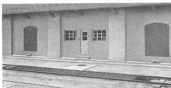
Fig. 2. — Pont à bascule pour wagons, capacité de pesage 50 t, sans interruption de voie, avec calage hydro-électrique, rampes d'accès mobiles, jeu de leviers en construction sans torsion, avec couteaux réglables et interchangeables, brevet Giroud.
