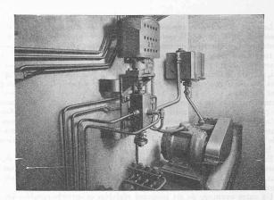
Fig. 16. — Pompe et soupapes de l'installation hydro-électrique du pont à bascule de 50 t, selon figures 2, 3 et 15.
