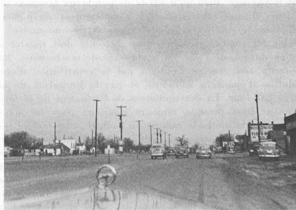
Fig. 13. — DÉTROIT, Michigan . Route Mich. 102 à Ferndale. Un des deux tronçons de routes chauffées pour le déblayage des neiges. On distingue les poteaux et les transformateurs d'aménée du courant.
