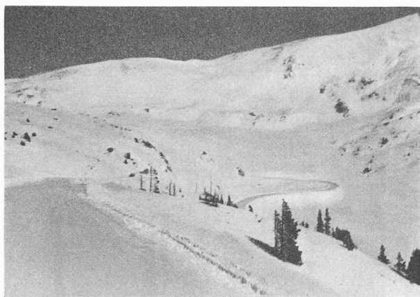
Fig. 6. — LOVELAND PASS, Colorado. Route US 6 à l'altitude [de 3600 m. Largeur utile déblayée de 10 m. environ.
