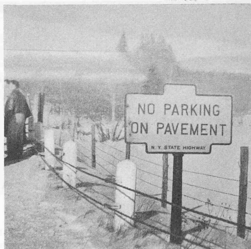
Fig. 10. — LAKE PLACID, New-York . Signal d'interdiction de stationner sur le revêtement. Remarquer aussi le type de barrière composée de gros poteaux en béton et de deux câbles métalliques horizontaux fixés à la hauteur du pare-choc.
