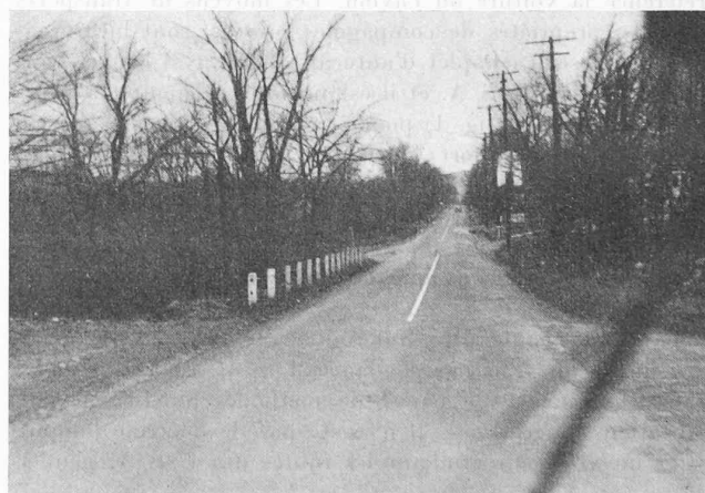
Fig. 5. — WALDEN, New-York. Route fédérale étroite et à profil défectueux.
