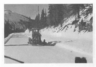
Fig. 16. — LOVELAND PASS, Colorado. Grader à lame en dents de scie. La surface de la neige durcie, ainsi traitée, devient rugueuse et permet de circuler jusqu'à 3600 m d'altitude sans chaînes à neige. On distingue mal sur la figure les stries obtenues.
