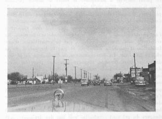
Fig. 13. — Détroit, Michigan. Route Mich. 102 à Ferndale. Un des deux tronçons de routes chauffées pour le déblayage des neiges. On distingue les poteaux et les transformateurs d'amenée du courant.
