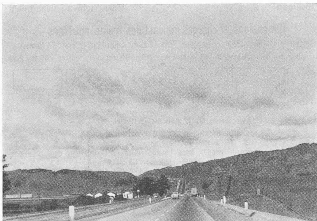
Fig. 9. — SAN-FRANCISCO-SACRAMENTO, Californie . Autoroute, composée de deux voies pour chaque sens. Les banquettes latérales traitées plus sommairement que la chaussée, servent au stationnement.
