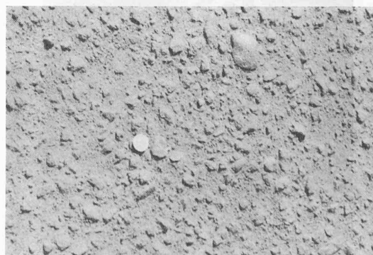
Fig. 8. — IDAHO SPRINGS, Idaho. Tapis de mortier bitumineux des routes US 6 et US 40, extrêmement rugueux. La pièce de monnaie au centre de la figure a un diamètre de 24 mm.
