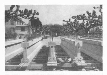
Fig. 8. — Les poutres principales fabriquées sur la rive.
