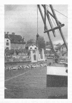
Fig. 4. — Transport des selles d'appui.
