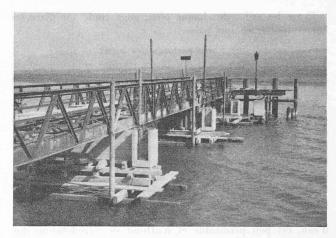
Fig. 5. — Les selles d'appui sont en place.
