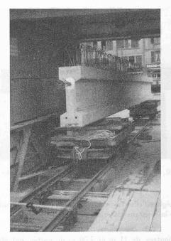
Fig. 9. — Transport d'une poutre principale de 11 tonnes.
