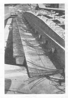
Fig. 17. — Précontrainte transversale assurant la solidarité des sept poutres du pont-rail.
