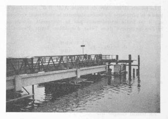
Fig. 11. — Les poutres de la passerelle sont posées.
