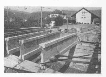
Fig. 21. — Les poutres du pont-route sont en place.
