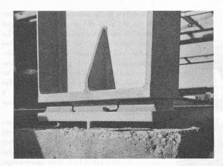
Fig. 8. - Appui articulé d'un pinier.
