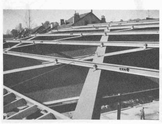
Fig. 9. — Pannes. Le vide entre les pannes et la charpente porteuse correspond à l'épaisseur du plafond.
