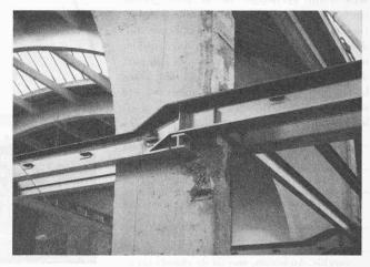
Fig. 11. — Console d'appui des sommiers DIN 42,5 traversant de part en part le pilier en béton armé de 40 cm d'épaisseur de la halle I.
