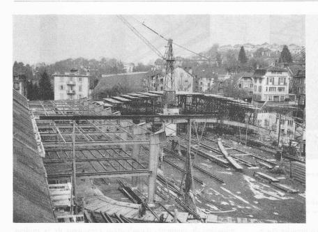
Fig. 12. — Vue générale du chantier, un mois après le début des travaux. On remarquera au sol l'assemblage des tronçons d'arc.
