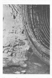
Fig. 14. — Extrémité amont du ferraillage du revêtement de la galerie situé immédiatement à l'amont de la culotte. (Remarquer les boutonnières d'ancrage des aciers durs sur les cerces à section carrée d'about).
