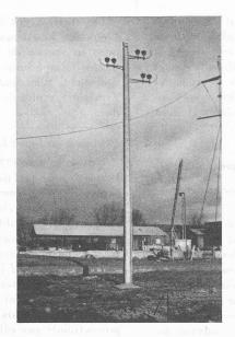
Fig. 18. — Poteau type « Génie rural ». Hauteur totale 11,00 m. — Hauteur hors-sol 9,30 m. — Poids total 900 kg. — Poids d'acier 78 kg. — Effort de fissuration 400 kg en tête. — Effort de rupture 825 kg en tête.
