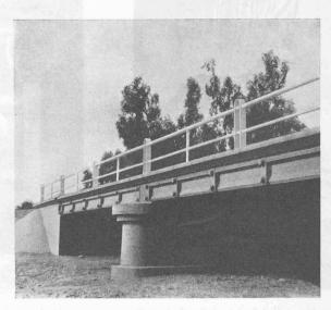
Fig. 20. — Pont sur l'Oued Saad en Tunisie, comprenant deux travées constituées par des poutres de 10 m jointives.
