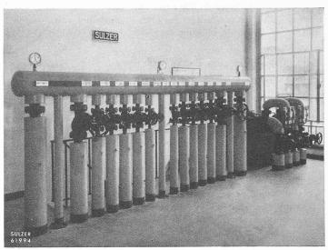
Fig. 32. — Local de réglage. Pompes et nourrice de l'eau surchauffée.
