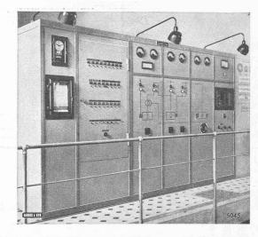
Fig. 10. Tableau de l'installation de télécommande des Services d'Electricité de la Ville de Zoug.
