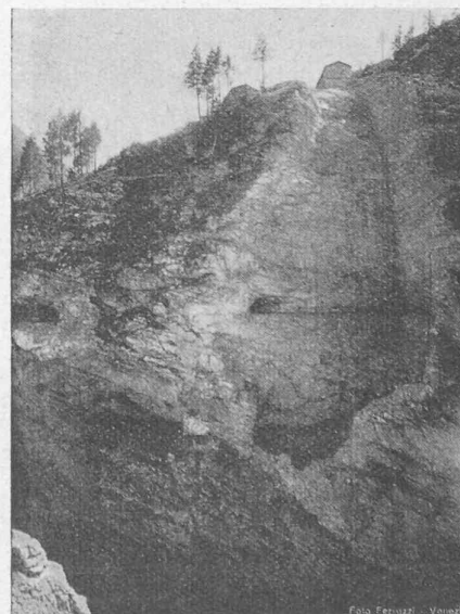
Fig. 7. Barrage du Piave. Excavation de la culée droite.
