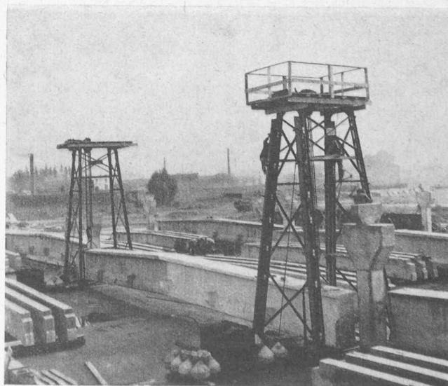
Fig. 10. — Usine textile à Gand. Vue générale avant pose des dalles préfabriquées.
