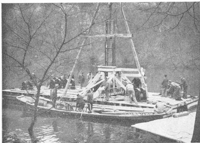
Fig. 12. — La traversée du Rhône : le tirage.
