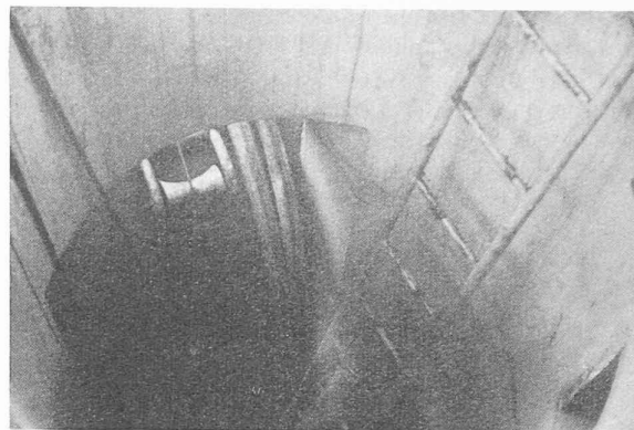
Fig. 6. — La descente du câble dans la cheminée.
