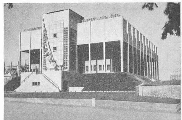
Fig. 1. — Réservoir d'eau de la ville d'Orléans (contenance 7000 m 3 ). On distingue à gauche les poteaux du deuxième réservoir en construction.
