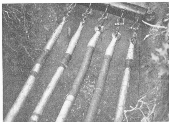
Fig. 14. — L'extrémité tirée des câbles.
