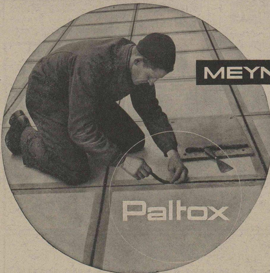
Le mastic étanche éprouvé dont l'adhérence et l'élasticité demeurent permanentes; s'emploie à froid pour les joints de dilatation, les raccords, etc.
