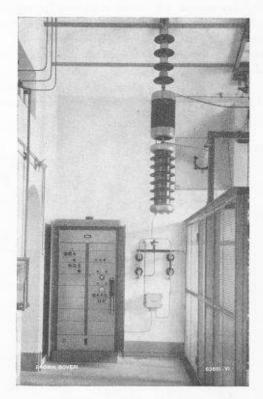
Fig. 2 — Installation de téléphonie par ondes porteuses pour centrales électriques, avec transmission simultanée d'une télémesure.
