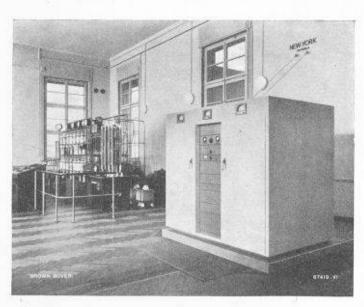
Fig. 1 — Emetteur 10 kW à ondes courtes dans la station de Münchenbuchsee de la société Radio Suisse, Cet émetteur est utilisé pour le trafic télégraphique et avec téléscripteur avec New-York. Il est caractérisé par sa construction simple et ses dimensions très restreintes et son temps de montage très court.
