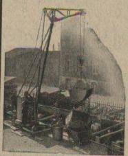
La petite grue RACO, exécution brevetée, se distingue par certaine avantages qui se font déjà valoir lors du montage et tout particulièrement pendant le service. Son montage pour le travail prévu se fait en quelques instants et la transformation de la portée, de la hauteur d'élévation et de la force portante au gré des besoins, ne demande que quelques minutes. La construction de la petite grue RACO est solide et elle lui garantit une longue durée d'existence.
