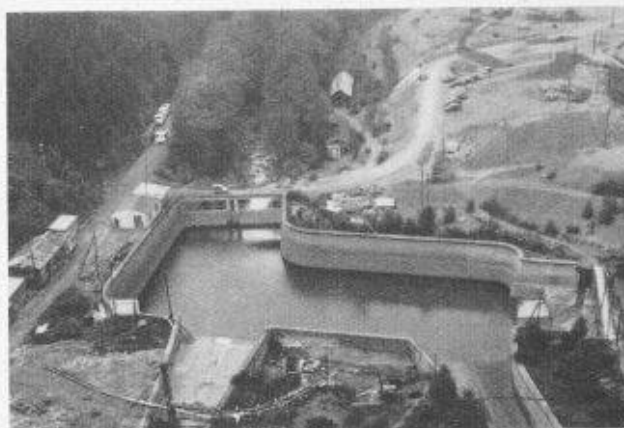
Fig. 2. — Barrage sur la Vesdre. — Bassin de décharge.
