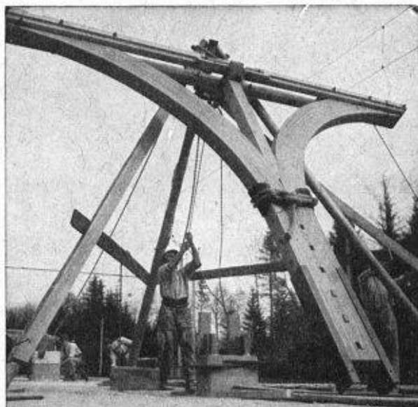
Supports, « système Hetzer », pour le quai de la gare de Ramsei Constructeur: Gribi & Cie S. A., Berthoud
