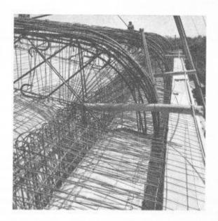
Fig. 8. — Détail : armature de l'angle supérieur des fermes à la racine du porte à faux de 10 m,
