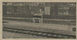
Pont à bascule pour chemins de fer. Capacité de pesage de 70 tonnes. Type normal des CFF avec pont en béton à nervures, longueur 11,6 m, construction Giroud, permettant le passage de locomotives d'un poids de 120 tonnes.
