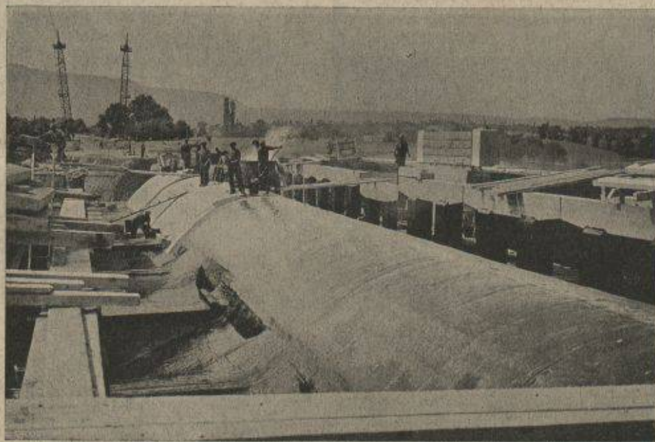
Revêtement étanche sur voûte de pont
