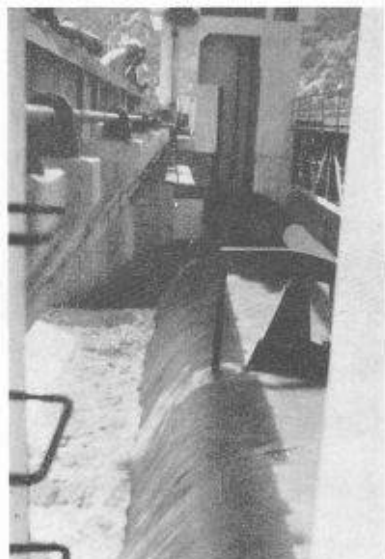
Fig. 5. — Déversement sur la hausse abaissée.
