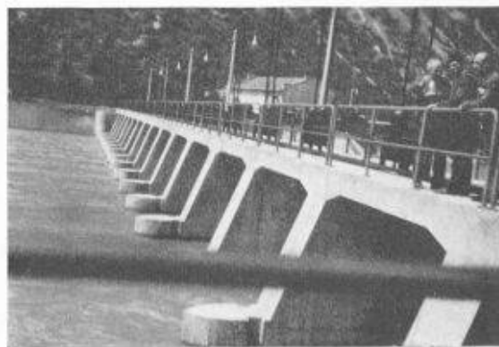
Fig. 8. — L'ouvrage de prise, vue d'aval.
