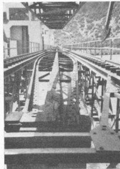
Fig. 6. — Élément de batardeau en réserve.
