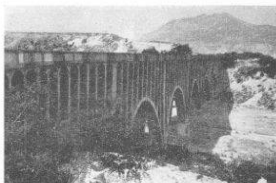
Fig. 11. — Pont-canal sur la vallée du Tasso.
