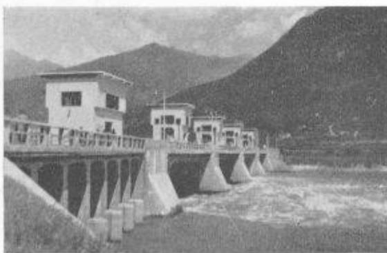
Fig. 7. — Le barrage, vue d'aval.
