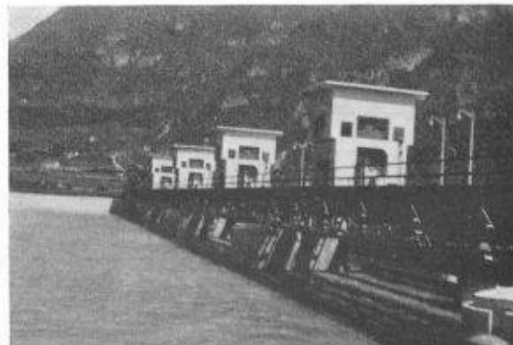
Fig. 3. — Le barrage, vue d'amont.
