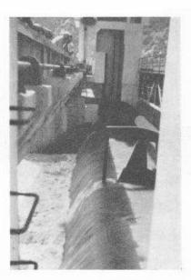
Fig. 5. — Déversement sur la hausse abaissée.
