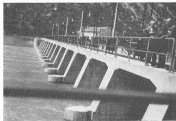
Fig. 8. — L'ouvrage de prise, vue d'aval.
