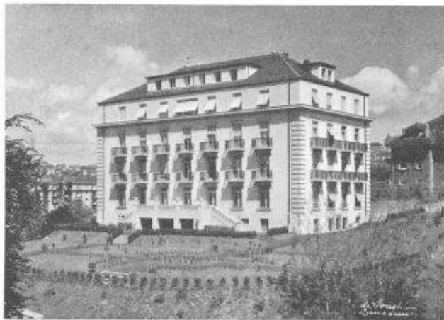
Fig. 39. — Clinique Montchoisi, Lausanne. Ch. Andrien, architecte S. I. A., Lausanne.
