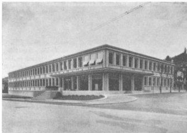
Fig. 7. — Bâtiment administratif de la Société romande d'électricité, Clarens. P. Bournoud, architecte F. A. S., Lausanne. A. Schorp, architecte S. I. A., Montreux.
