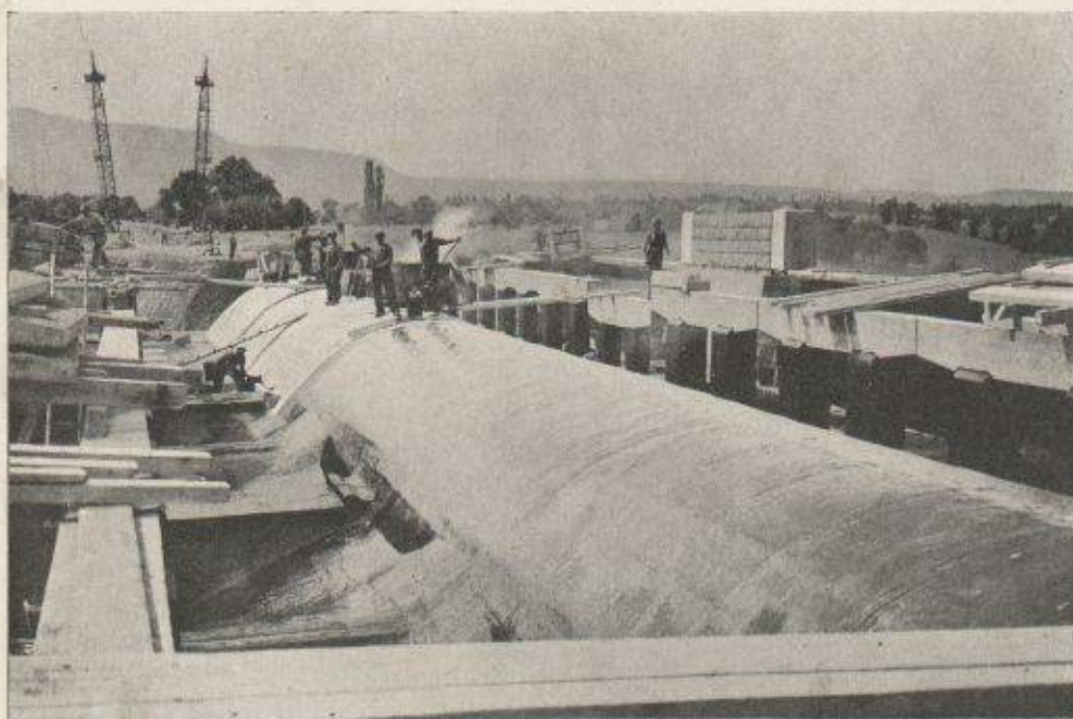
Revêtement étanche sur voûte de pont
