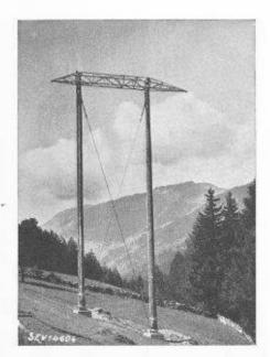
Fig. 4. — Support d'alignement/angle avec socles de fondation.
