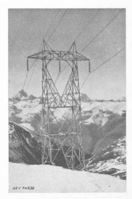
Fig. 6. — Pylône en treillis métallique, près du col du Nufenen.
