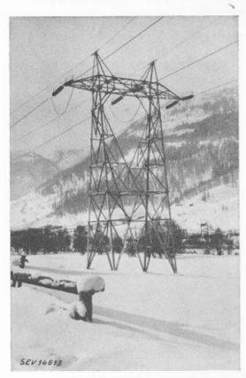
Fig. 5. — Pylône d'angle/ancrage en treillis métallique.
