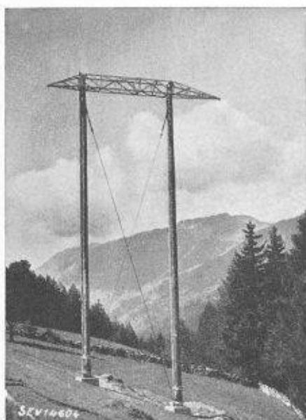
Fig. 4. — Support d'alignement/angle avec socles de fondation.
