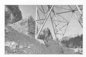
Fig. 8. - Mur de protection, type petit.
