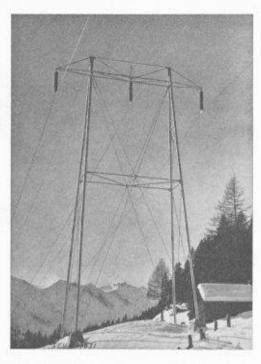
Fig. 7. — Pylône d'alignement en treillis porteurs formés de tubes d'acier remplis de béton.
