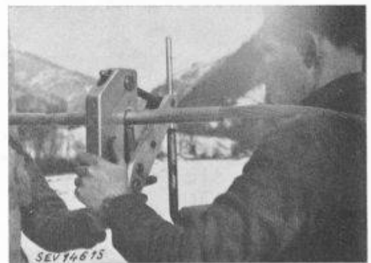
Fig. 16. — Renforcement d'une soudure « Alutherm » par joint tubulaire — Encochage avec presse à main.
