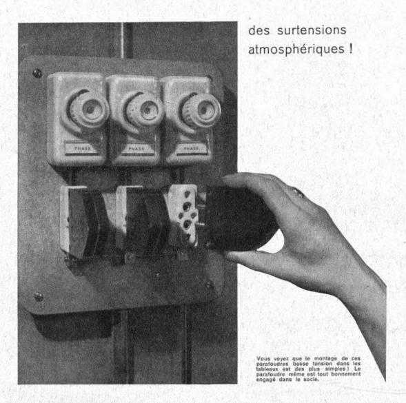
Les parafoudres basse tension placés correctement réduisent le nombre des compteurs et des lampes détériorés par les surtensions atmosphériques. Ces parafoudres sont rapidement amortis! Ils ne nécessitent aucune surveillance et aucun entretien, ils sont toujours en état de fonctionner.
