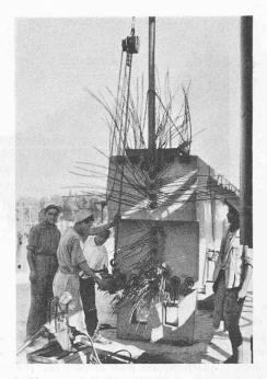
Fig. 16. - Précontrainte d'une poutre.
