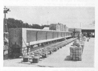
Fig. 9. — La poutre de 28,80 m sous charge (24 tonnes en briques béton).
