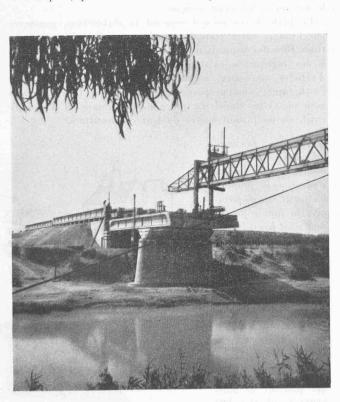
Fig. 17. — Vue de la passerelle de montage en position pour le lancement de la première poutre-cantilever.
