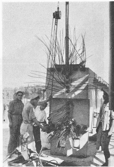
Fig. 16. — Précontrainte d'une poutre.
