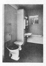
Fig. 13. — Salle de bains, bloc eau, de Schindler-Goehner.
