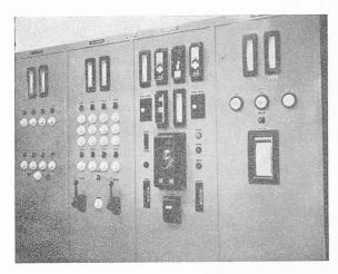
Fig. 12. — Poste de Rolle. Tableau 13 kV et des services auxiliaires.
