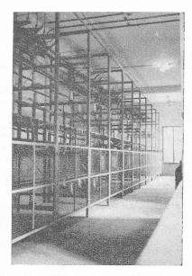
Fig. 10. — Poste de Rolle. Sectionneurs et barres 13 kV.
