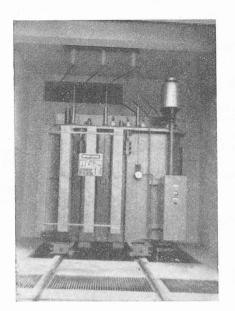
Fig. 17. — Poste de Nyon. Transformateur à gradins de 3500 kVA.
