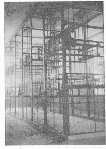
Fig. 21. — Poste de Nyon. Barres et sectionneurs 13 kV.
