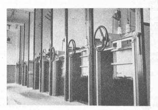
Fig. 9. — Poste de Rolle. Disjoncteurs 13 kV de lignes.
