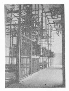
Fig. 20. — Poste de Nyon. Appareillage 13 kV et commandes des disjoncteurs à faible volume d'huile.
