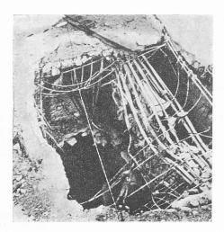
Fig. 31. — Pont de Moscou. Armatures principales détruites.
