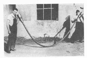
Fig. 4. — Armature autoprécontrainte de M. Chalos.
