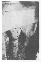
Fig. 15, 16 et 17. — Reprise en sous-œuvre du Palais Rihour, à Lille. — Différentes phases de l'opération.
