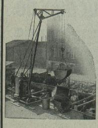
La petite grue RACO, exécution brevetée, se distingue par certains avantages qui se font déjà valoir lors du montage et tout particulièrement pendant le service. Son montage pour le travail prévu se fait en quelques instants et la transformation de la portée, de la hauteur d'élévation et de la force portante au gré des besoins, ne demande que quelques minutes. La construction de la petite grue RACO est solide et elle lui garantit une longue durée d'existence.
