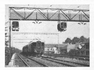
Fig. 13. — Signaux avancés d'entrée avec dispositif d'arrêt automatique.
