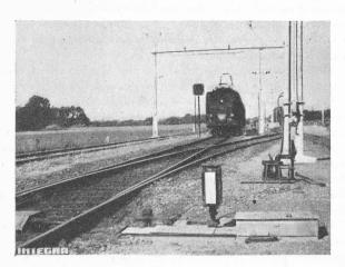
Fig. 4. — Moteur d'aiguille et signal avancé de sortie.
