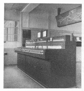
Fig. 2. — Poste directeur de Neuchâtel. Appareil Siemens classique.
