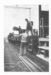
Fig. 5. — Grues Robel pour manutention des longs rails.
