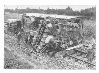
Fig. 1 et 2. - Cribleuse-dégarnisseuse Scheuchzer.
