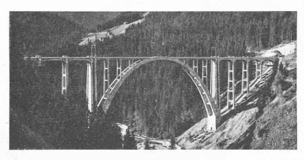
Fig. 8. Viaduc de Langwies. Chemin de fer rhétiques, ligne Coire-Arosa. Ouverture : 100 m.
