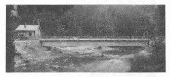
Fig. 10. — Pont sur la Birse près de Bärschwil, ligne Delémont-Bâle. Construction combinée poutres métalliques et dalle en béton. Deux travées de 20 m.
