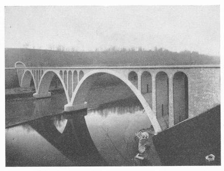
Fig. 13. — Pont de la Jonction, sur le Rhône et l'Arve, à Genève. Construction en béton avec parements en moellons. Voûtes de 46+52+58 m.
