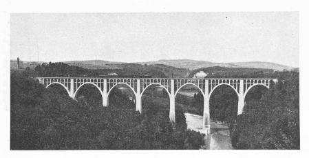
Fig. 14. — Viaduc de Grandfey sur la Sarine, près de Fribourg. 7 voûtes de  $39,10+5\times42,30+39,10$  m d'ouverture. Béton armé système Melan.
